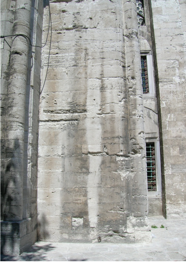
Şekil 5: Cerrahpaşa Camii'nin beden duvarlarında kesme taş şeklinde kullanılan İstanbul Taşı'nda meydana gelen farklı türdeki bozunmalar ve yıpranmalar.
